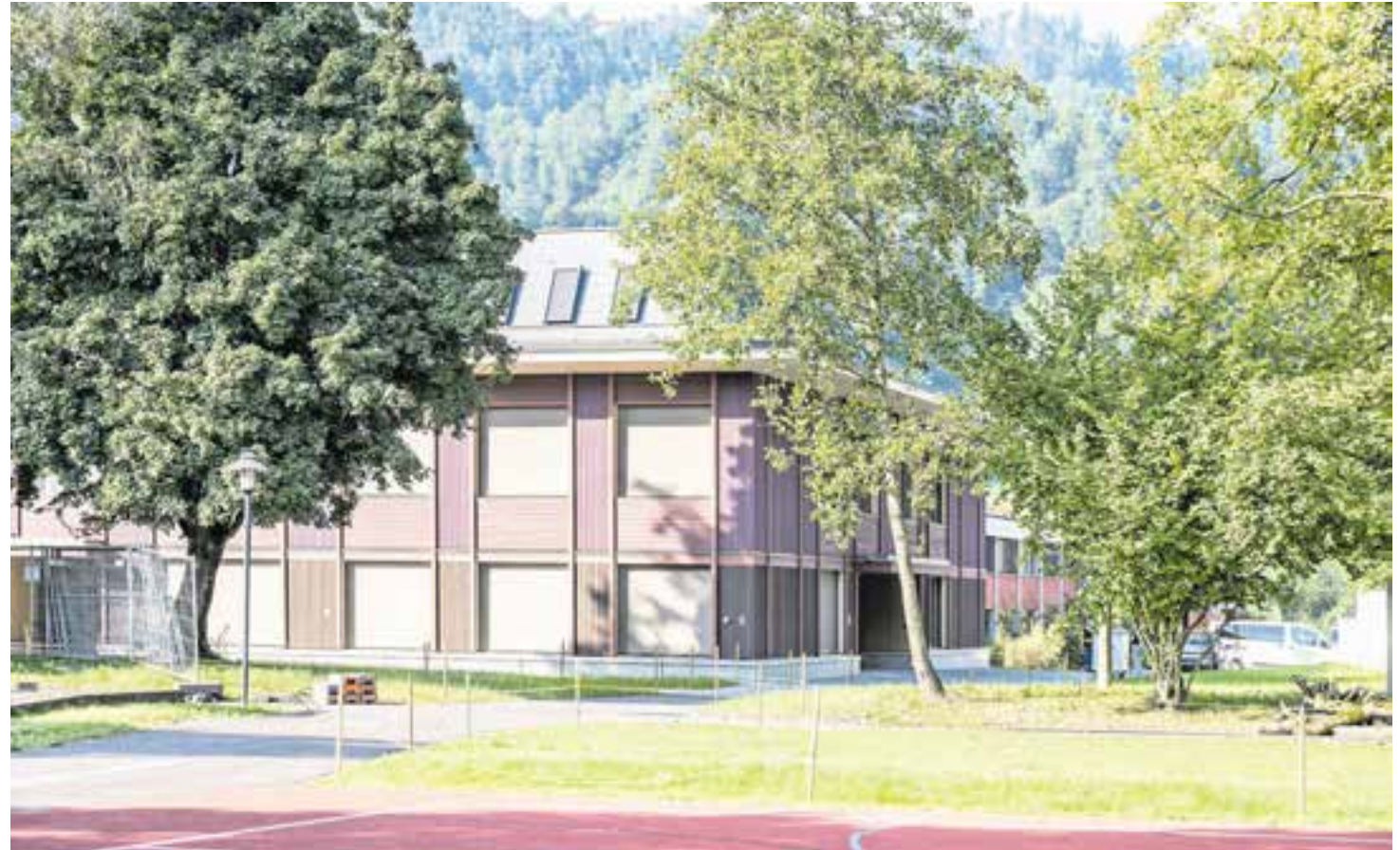
Das neue Schulhaus der sozialpädagogischen Schule Formidabel in Malters.
